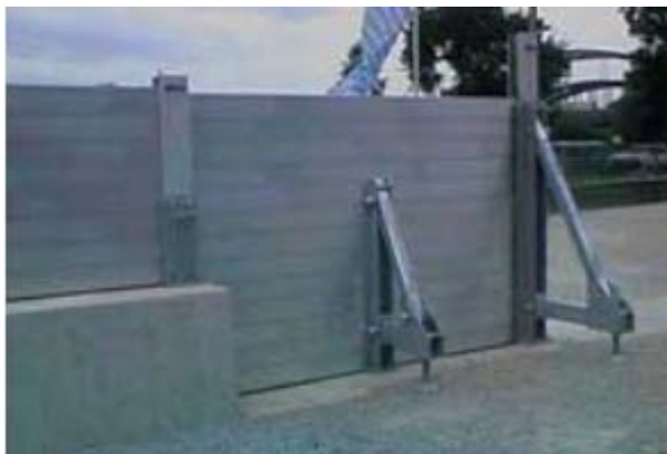
Figuur 6: Mogelijke uitvoering van een mobiele waterkering
