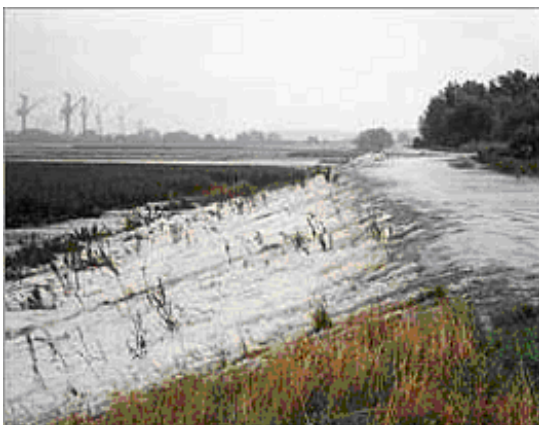
Figuur 3: Scheldewater stroomt over de overlooppdijk het GOG van Tielrode in
